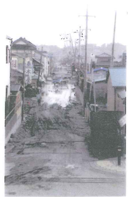
佐原駅の北口一帯の液状化被害
