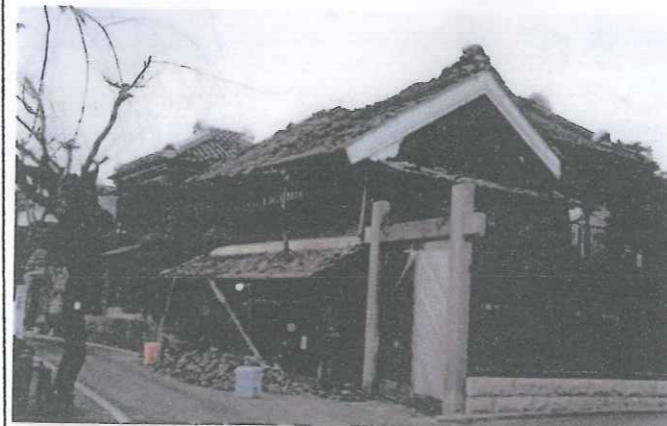
正上醤油の被害状況
