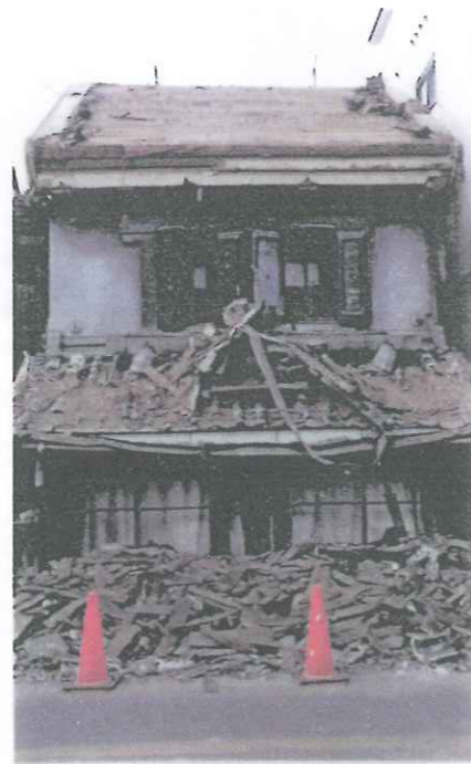
正文堂の被害状況
