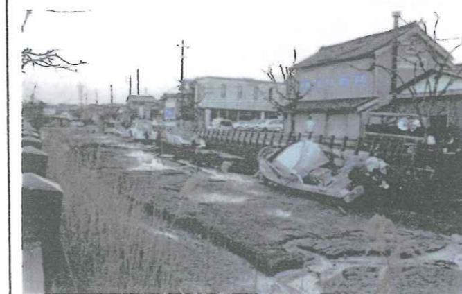
小野川下流、液状化で川底の土が地表まで噴出
